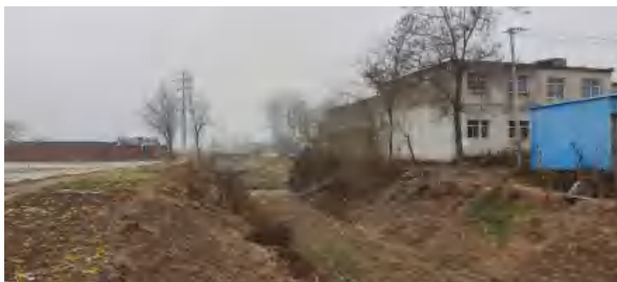
图5-15 西牛沟中桥桥址处现状
