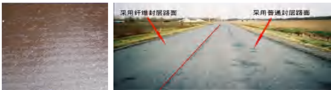
图5-48 玻璃纤维下封层
