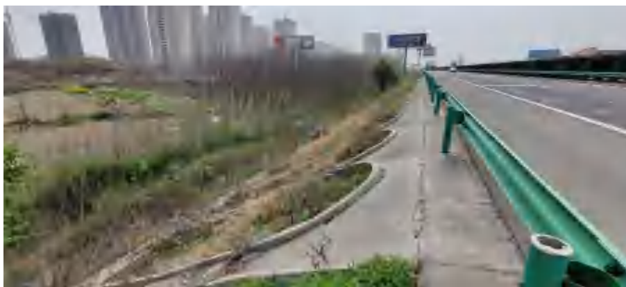
图5-13 京台高速分离式立交上跨桥桥址处现状
